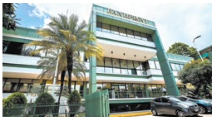
Instalaciones de BANHPROVI en Tegucigalpa.
