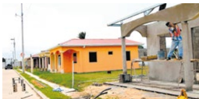
Personal de construcción desarrolló trabajos de construcción de vivienda clase social en Tegucigalpa.
