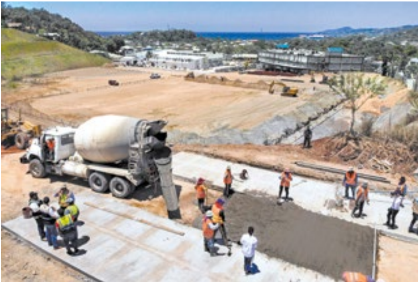
En la imagen, la maquinaria de la SIT con la construcción del hospital de emergencia de Roatán.
