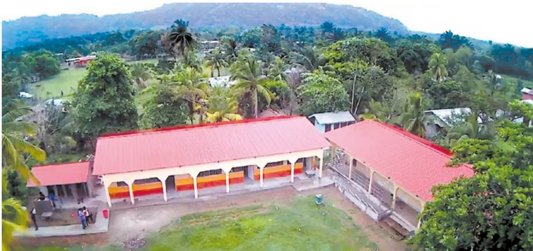
Toma aérea de la construcción del Centro de Educación Básica Álvaro Contreras, Río Tinto, Tela, Atlántida.
