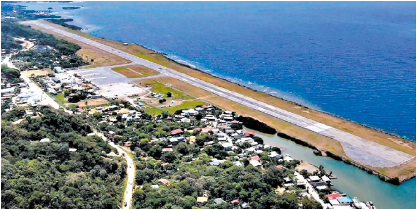
La ampliación del aeropuerto Juan Manuel Gálvez tiene un costo de L. 495.8 millones, el cual incluye la construcción de 6,000 metros cuadrados del inmueble.
