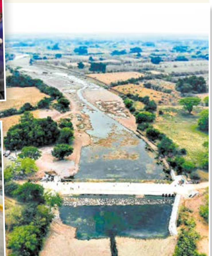
La obra de infraestructura beneficiará a más de 10 mil personas de 16 comunidades que se ven afectadas en temporada de lluvias.
