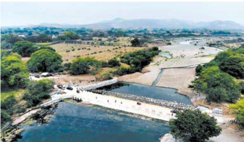
El costo de la obra del vado sumergible en el cauce de Ercilia, Alianza, Valle, es de 21.7 millones de lempiras, el cual beneficiará a más de 10 mil personas de 16 aldeas.
